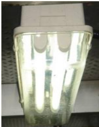
〈조명등 보호장치 설치 예시〉
